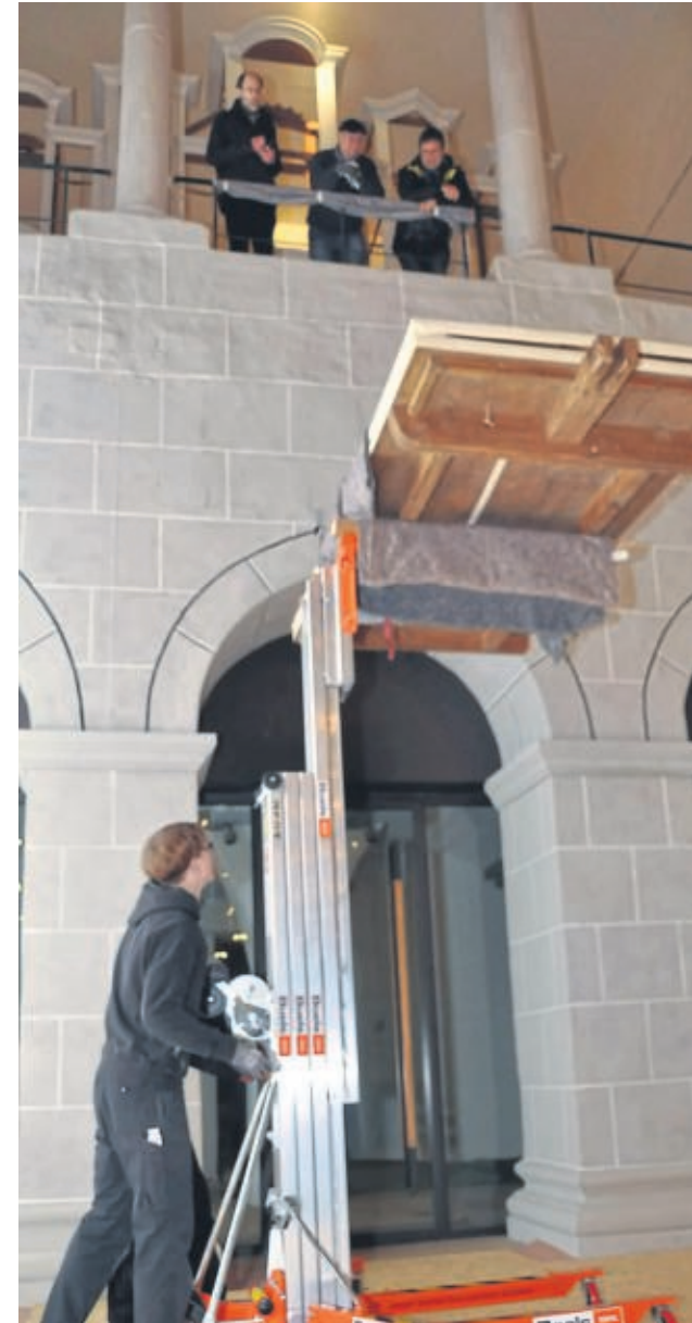
Zentimeterweise in die Höhe: Langsam und vorsichtig wird einer der drei 150 Kilo schweren Blasebälge mit der Handkurbel auf die Kaiserempore gehievt, auf der die Helfer schon warten.
