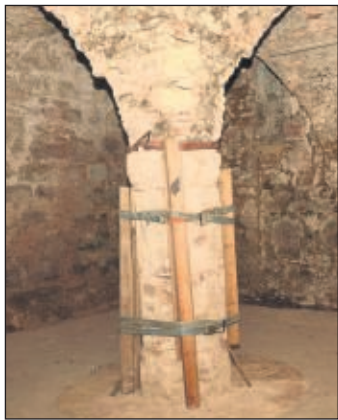
Soll ein Kleinod der Stiftskirche werden: Das Gewölbe unter der Kaiserempore wird demnächst saniert und erhält neue Zugänge.
